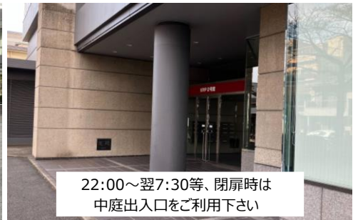
③ 建物東側から見た2号館 東出入口
