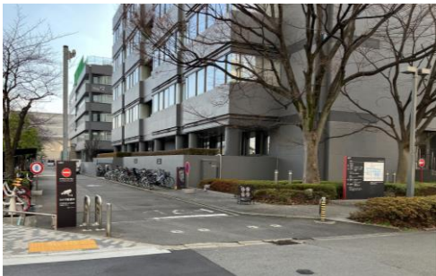
① 地区外北側から見た風景
