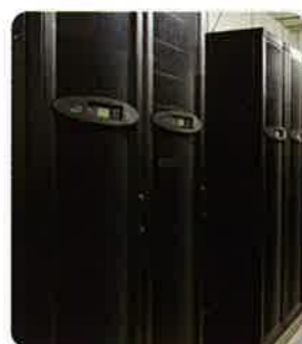
無停電電源装置
